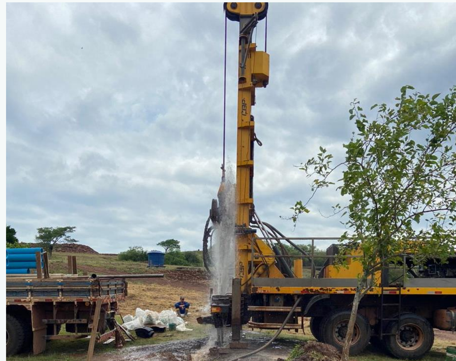
Perfuração de poços artesianos
