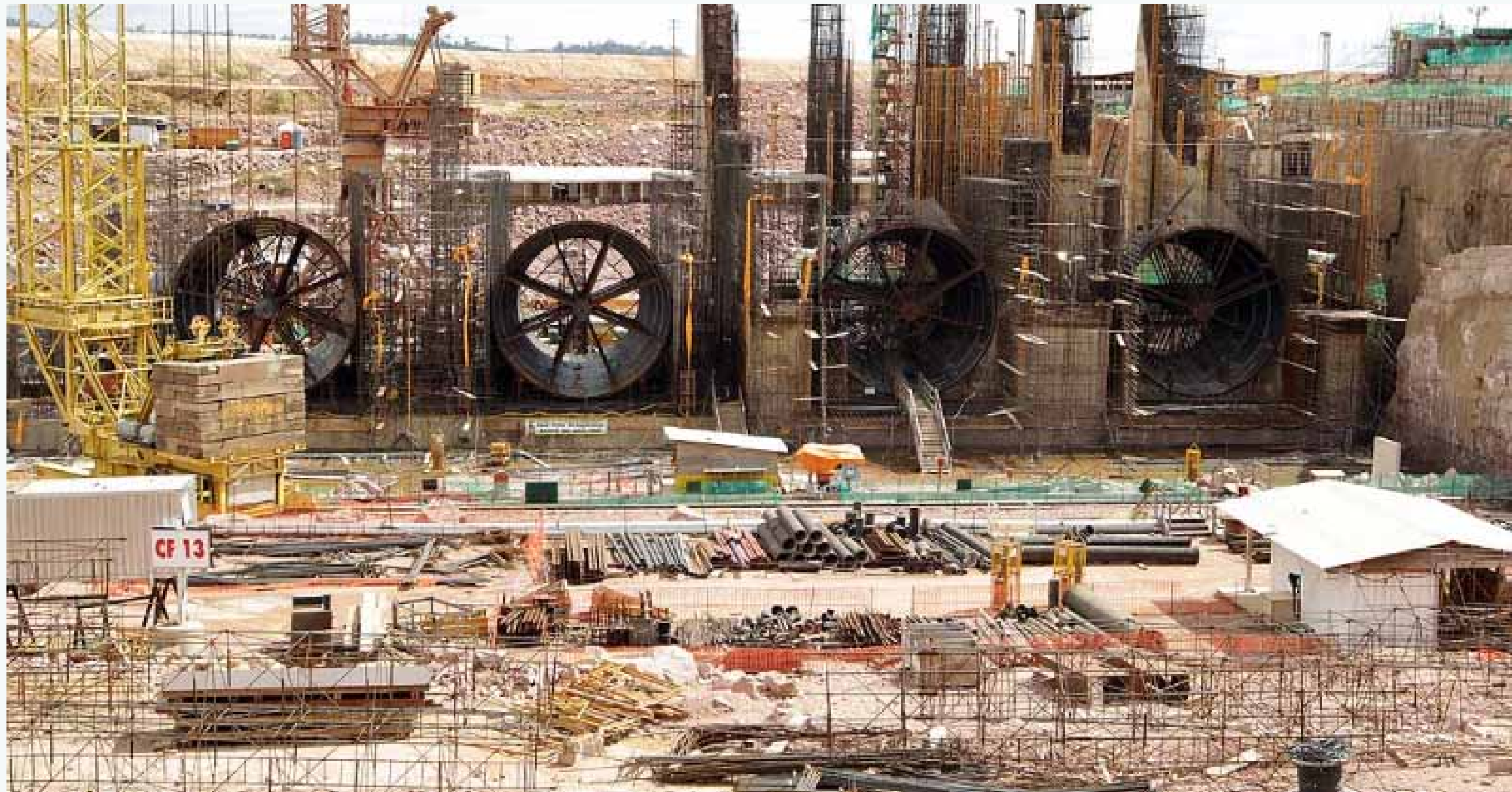
Construção de hidrelétrica
