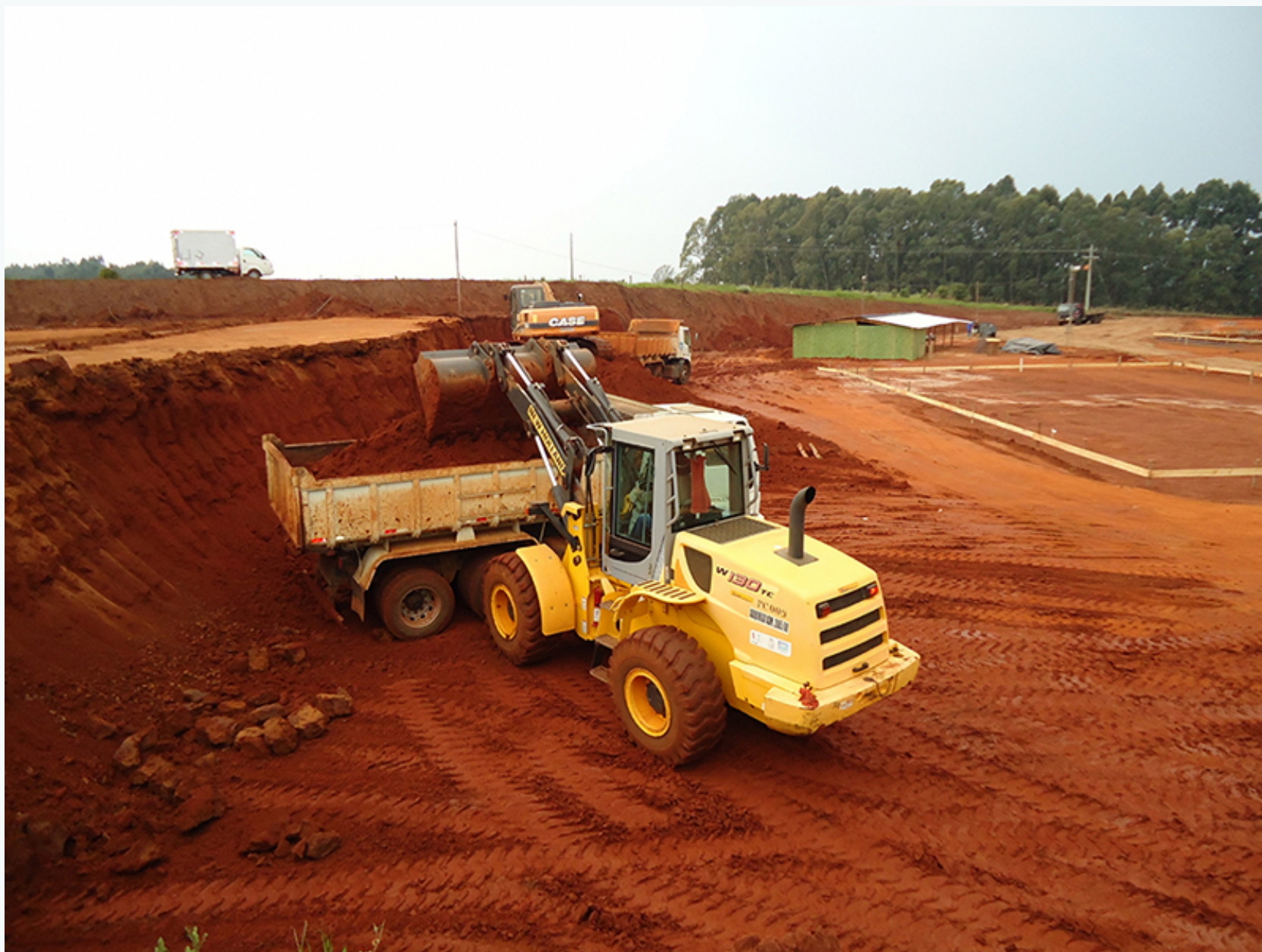
Obras com grande movimentação de terra
