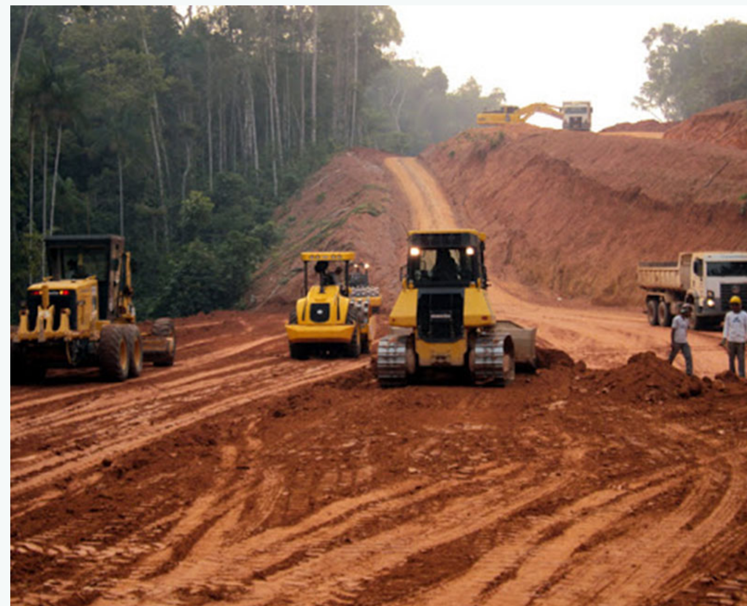
Serviço de terraplenagem
